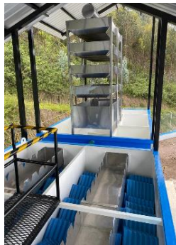
Fig. Sedimentador ABS 60 grados
